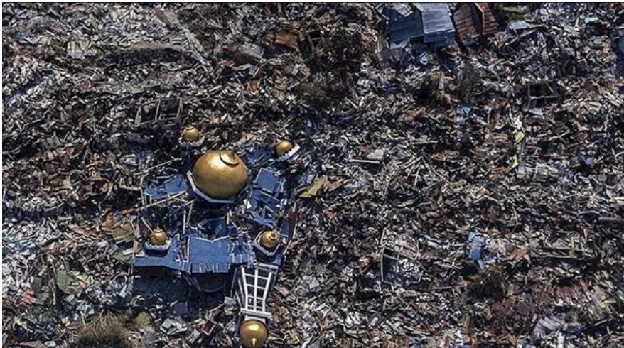
Gambar 66. Foto udara reruntuhan masjid di antara rumah-rumah warga di Perumnas Balaroa (Republika, 2018)
