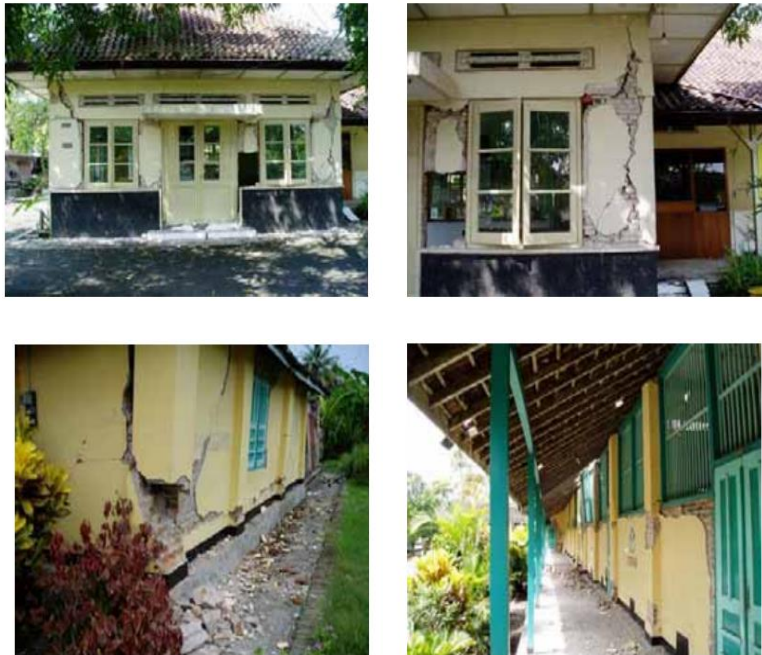
Gambar 40. Kerusakan pada Bangunan Balai Pengobatan Penyakit Paru-Paru (BP4) di Bantul (Elnashai, dkk., 2006).
