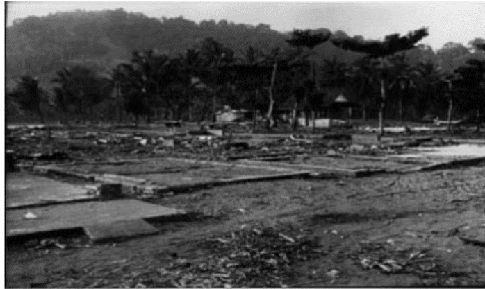
Gambar 35. Bangunan bambu rata dengan tanah seluruhnya di Rajekwesi. Kerusakan berat juga dialami bangunan batu bata.
