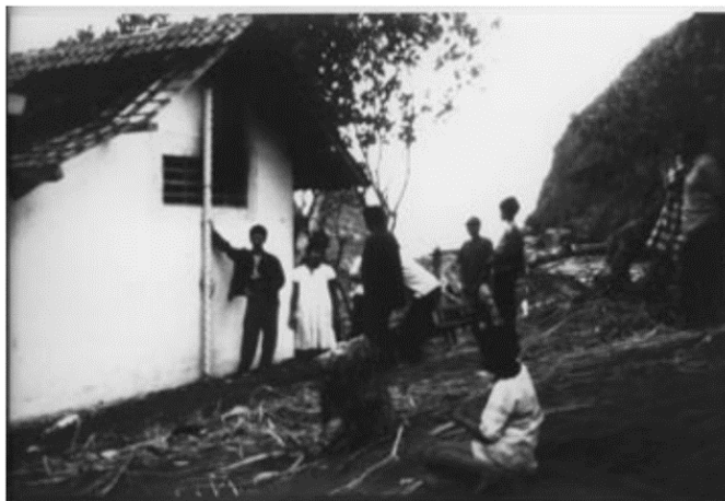
Gambar 34. Rumah yang mengalami kerusakan akibat diterjang gelombang tsunami dan teramati tiga gelombang berbeda ketinggian. Gelombang ketiga menyebabkan atap rumah runtuh.
