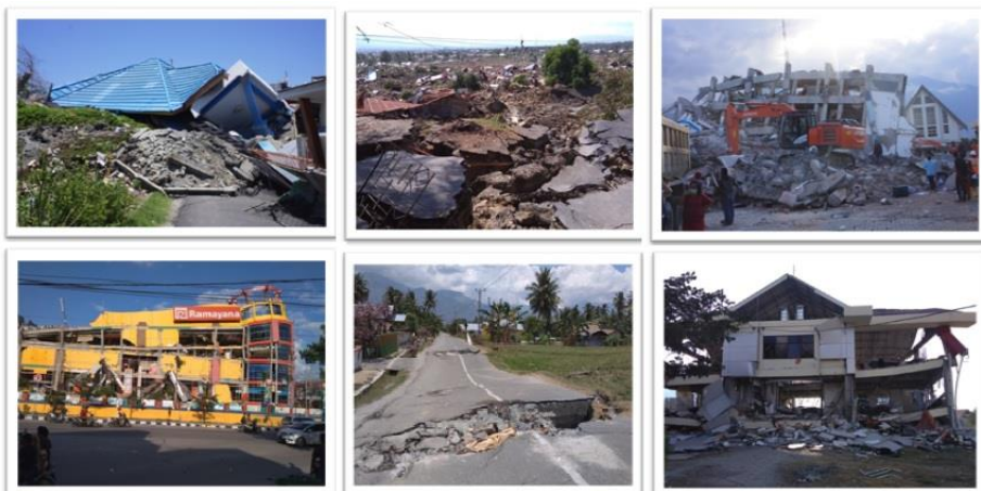
Gambar 69. Kerusakan bangunan akibat gempa Palu-Donggala hasil survei makroseismik tim BMKG
