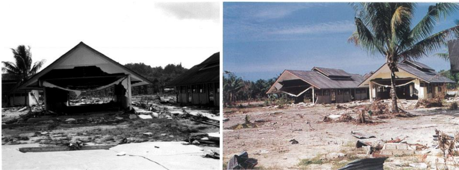
Gambar 76. Bangunan sekolah rusak akibat diterjang tsunami di Korim. Dinding yang menghadap ke arah pantai mengalami kerusakan berat akibat diterjang gelombang kuat (Matsutomi dkk., 2001, Imamura dkk., 1997).
