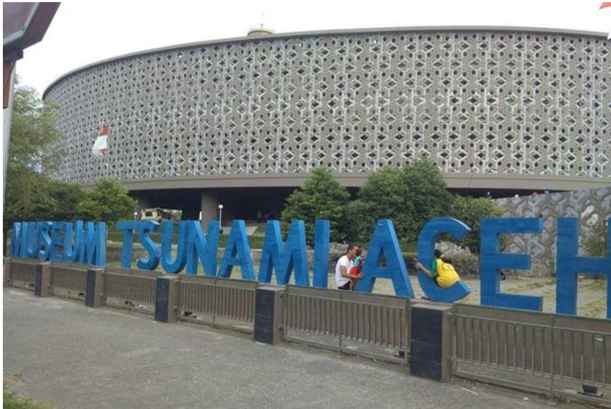
Gambar 16. Bangunan Museum Tsunami Aceh (Kompas, 2018)
