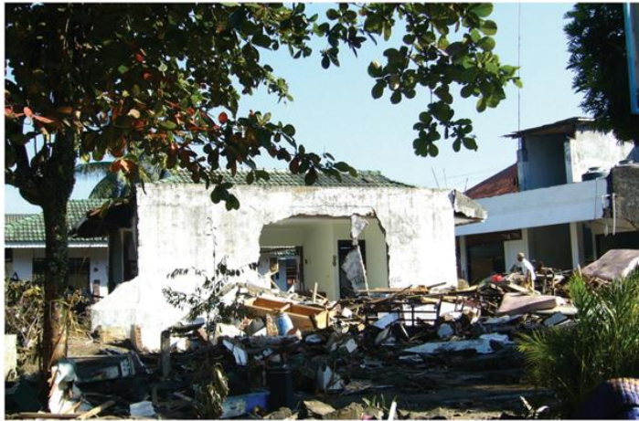
Gambar 46. Kerusakan tsunami pada bangunan batu bata yang tidak diperkuat strukturnya dengan kolom yang sesuai di Pangandaran (Mori, dkk., 2007).
